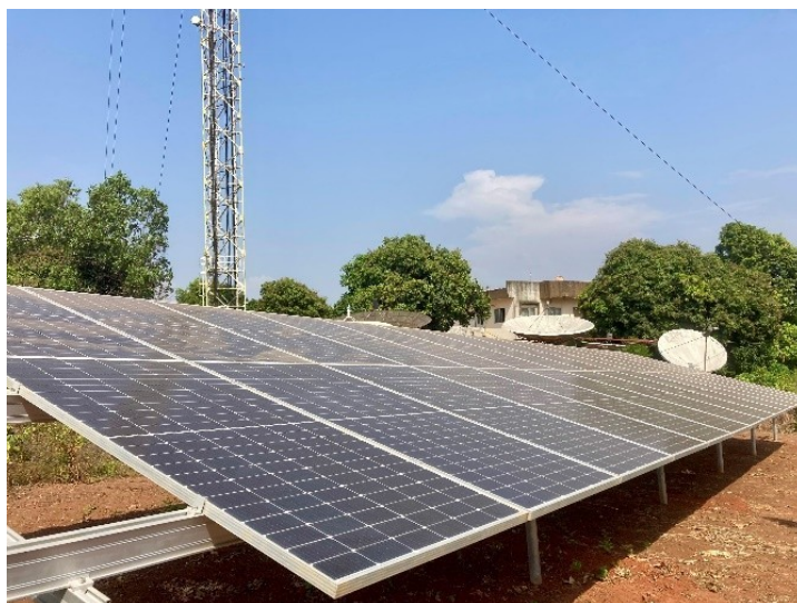
Le système solaire qui alimente l'émetteur FM à Cotonou
